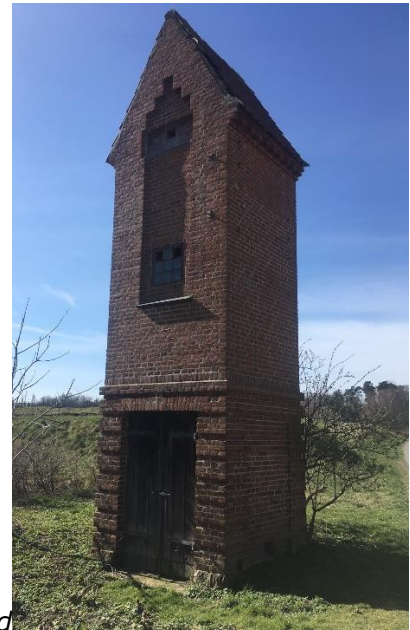
Figur 10. Transformatortårnet ved Dronningholm.
